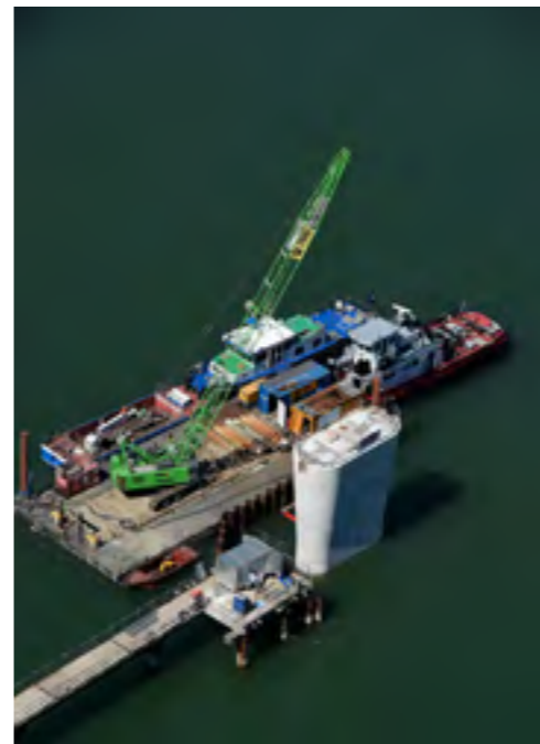
Un atelier flottant a été mis en place pour construire la pile centrale du pont, seul point d'appui immergé sur lequel reposent les deux tabliers.
