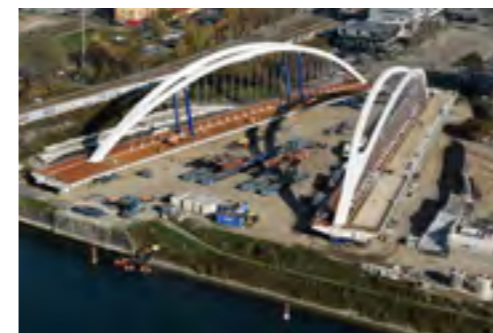
Acheminés sur le chantier par voie fluviale depuis la Belgique au printemps et à l'été 2015, les deux tabliers du pont ont été ensuite préparés sur la rive allemande.
